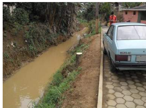
Figura 4-7: Trecho do Rio São Luiz paralelo à Rua Célia Freitas, vista jusante.
