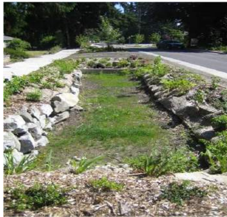
Figura 7-13: Trinchera de infiltração.
