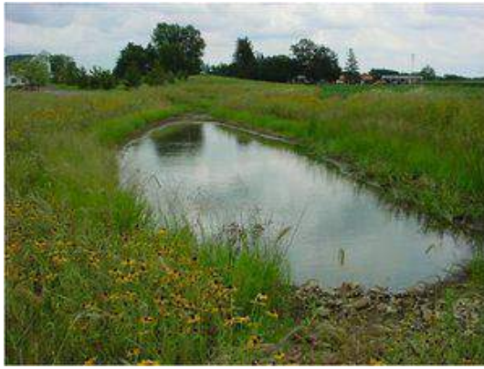
Figura 7-16: Bacia de retenção.
