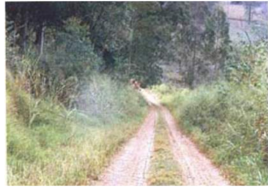
Figura 7-5: Taludes de corte e aterro e áreas não transitáveis recobertos com espécies herbáceas em estrada vicinal.
