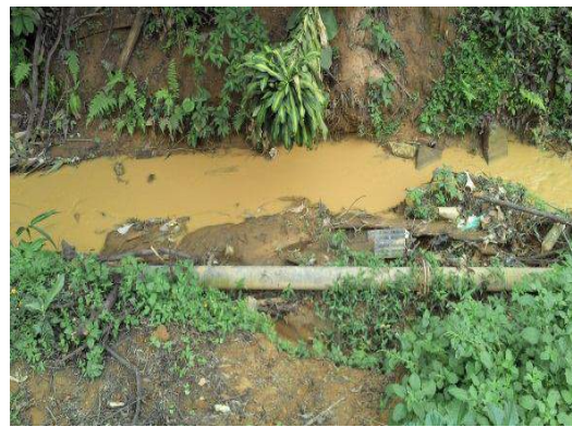
Figura 4-15: Tubulação de esgoto na margem do córrego Vila Jetibá.
