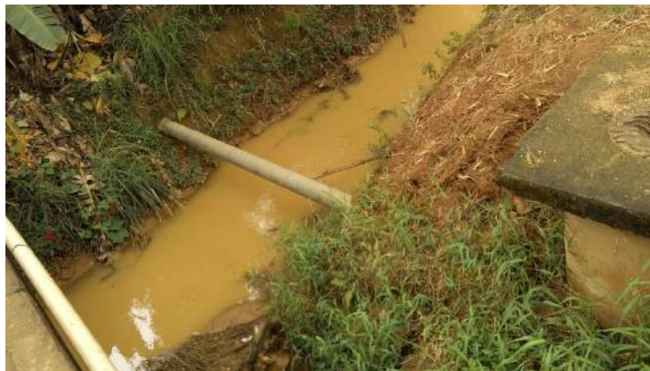
Figura 4-12: Tubulação de esgoto cruzando o Rio São Luiz.
