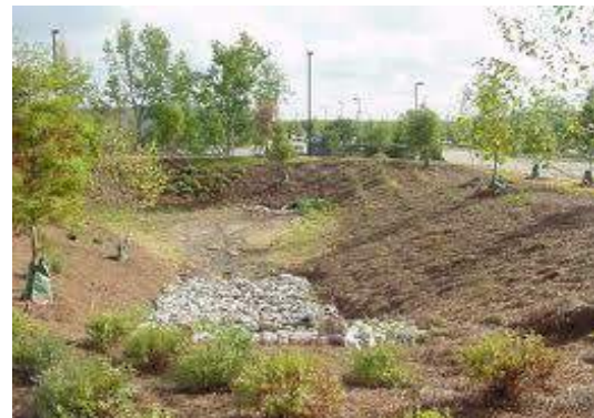
Figura 7-15: Bacia de detenção.
