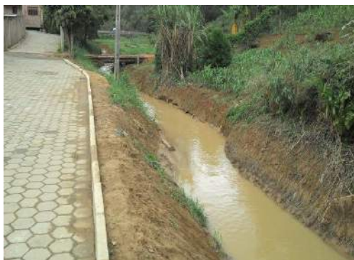
Figura 4-6: Trecho do Rio São Luiz paralelo à Rua Célia Freitas, vista montante.
