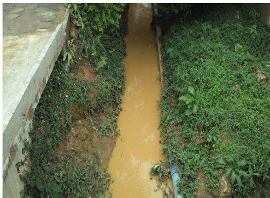
Figura 4-14: Tubulação de esgoto dentro do leito do córrego Vila Jetibá.
