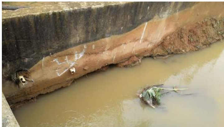
Figura 4-10: Muro de contenção da Rua do Imigrante, a jusante da ponte.
