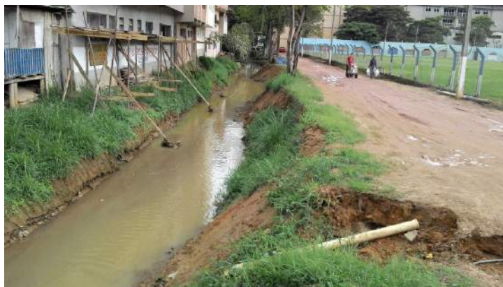
Figura 4-11: Estrutura de madeira temporária instalada no Rio São Luiz.
